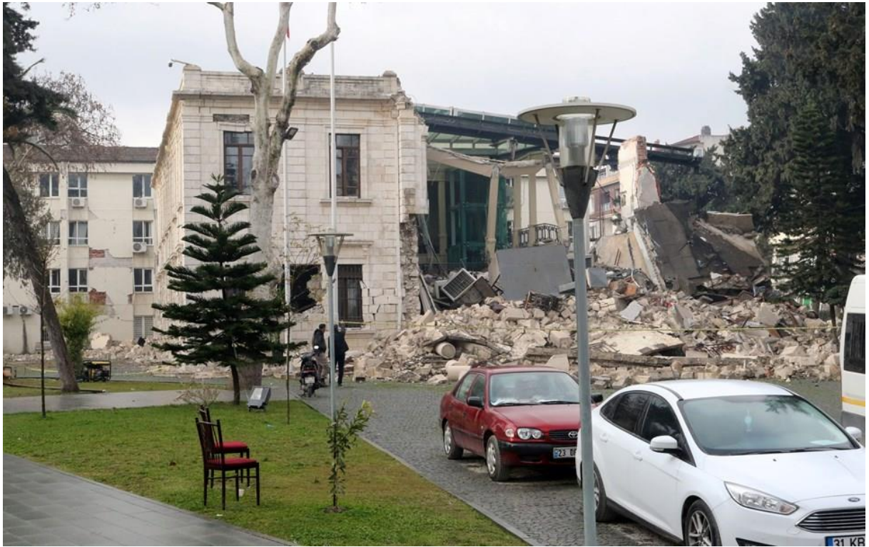
Hatay Valilik Binası-20 Şubat 2023 Depremleri Sonrası
