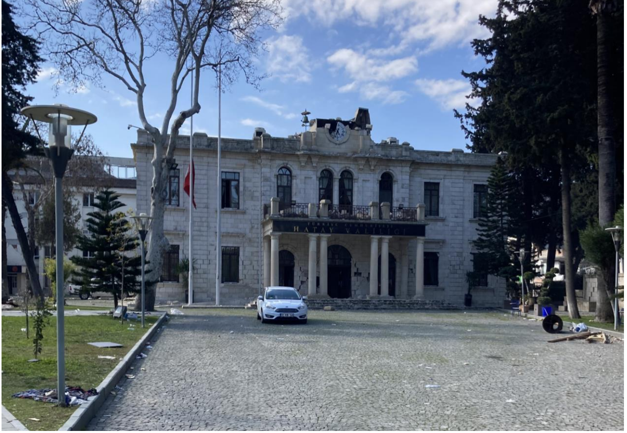
Hatay Valilik Binası-6 Şubat 2023 Depremleri Sonrası
