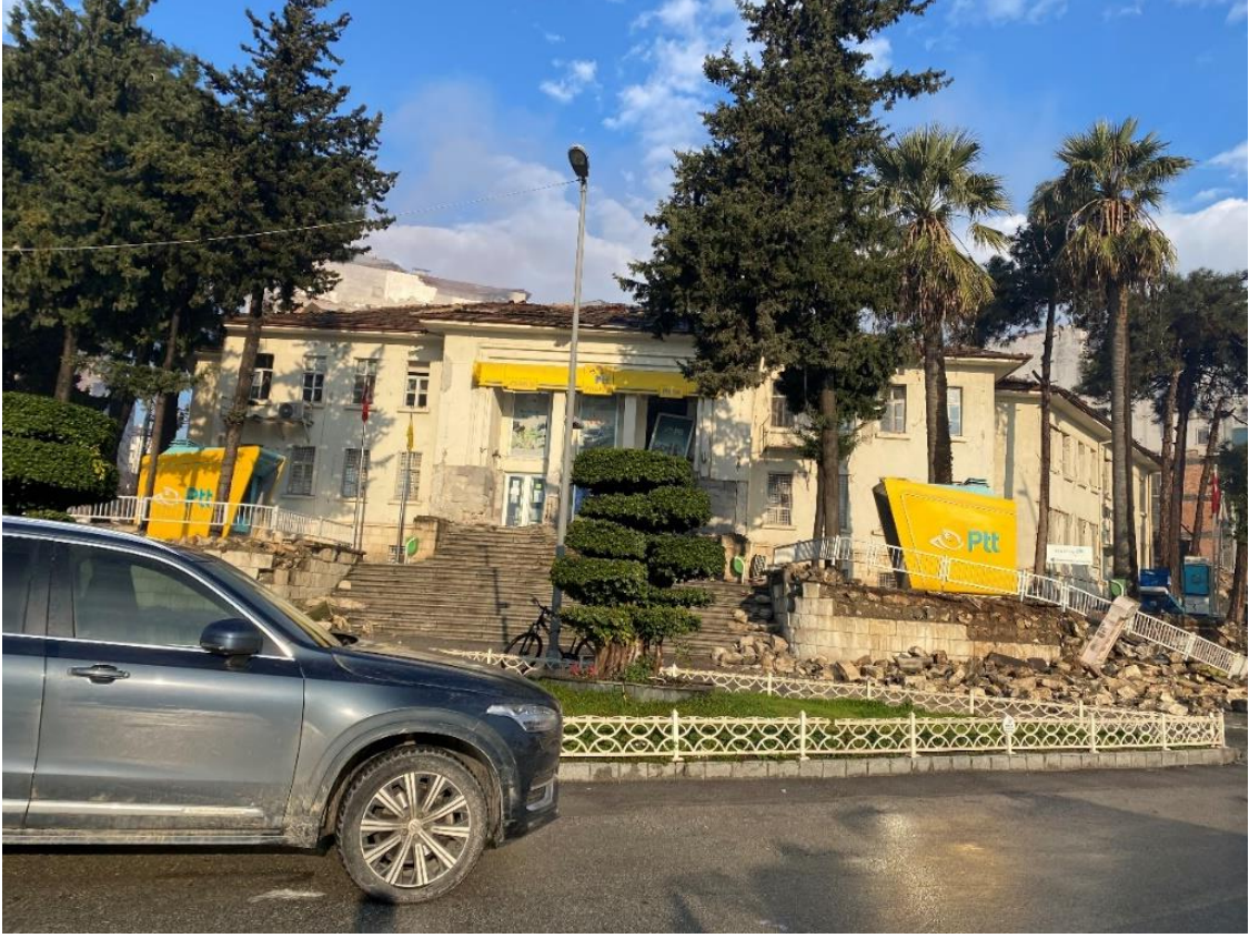
Hatay PTT Binası-6 Şubat 2023 Depremleri Sonrası
