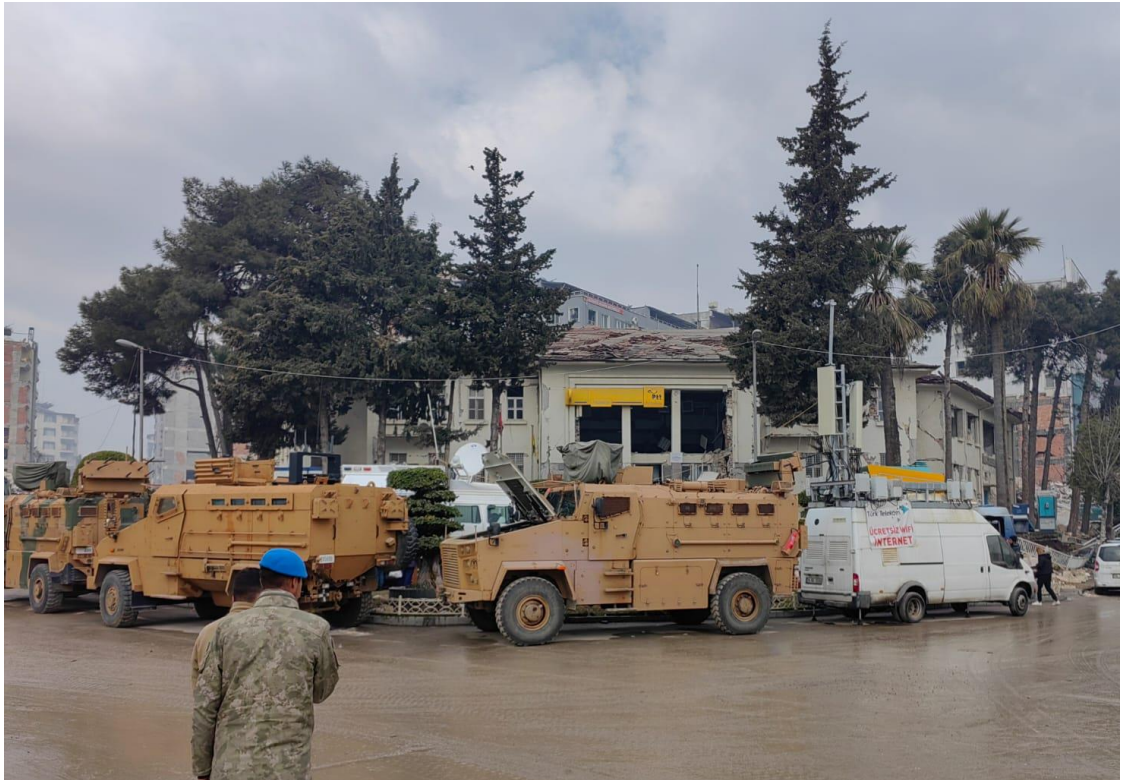
Hatay PTT Binası-20 Şubat 2023 Depremleri Sonrası
