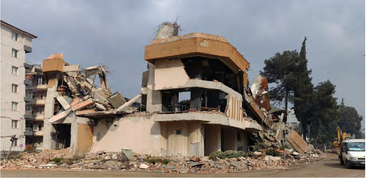
Hatay Kültür Merkezi 20 Şubat 2023 depremi sonrası hasar
