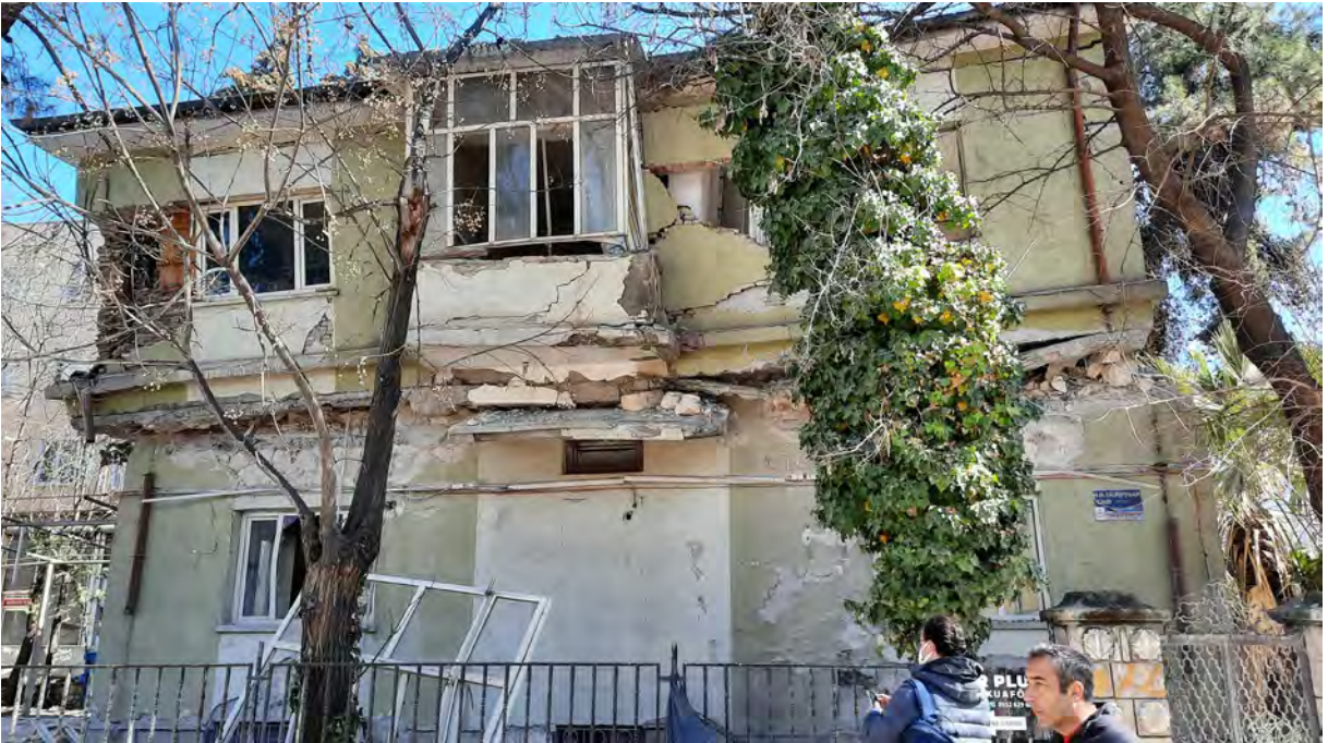
Adıyaman Orman Genel Müdürlüğü Lojman Binası
