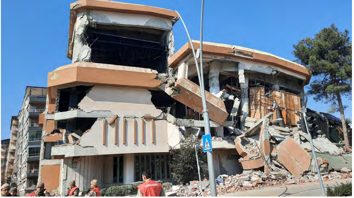
Hatay Kültür Merkezi 6 Şubat 2023 depremleri sonrası hasar
