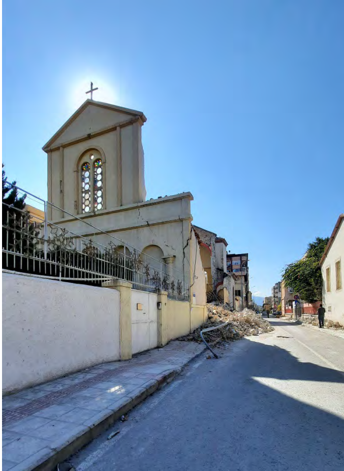
İskenderun Latin Katolik Kilisesi deprem sonrası hasar durumu
