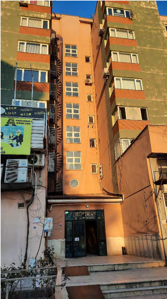
Mimarlar Odası Gaziantep Şubesi'nin bulunduğu İş Merkezi yapısı
