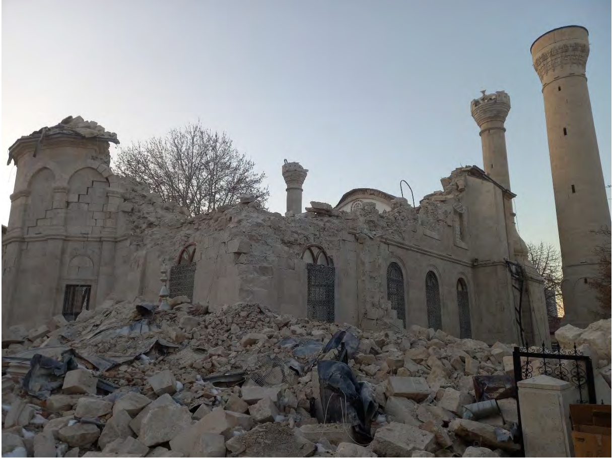
Malatya Ulu Camisi'nde deprem sonrası gözlenen hasarlar (Fotoğraf: Doç. Dr. Koray Güler)
