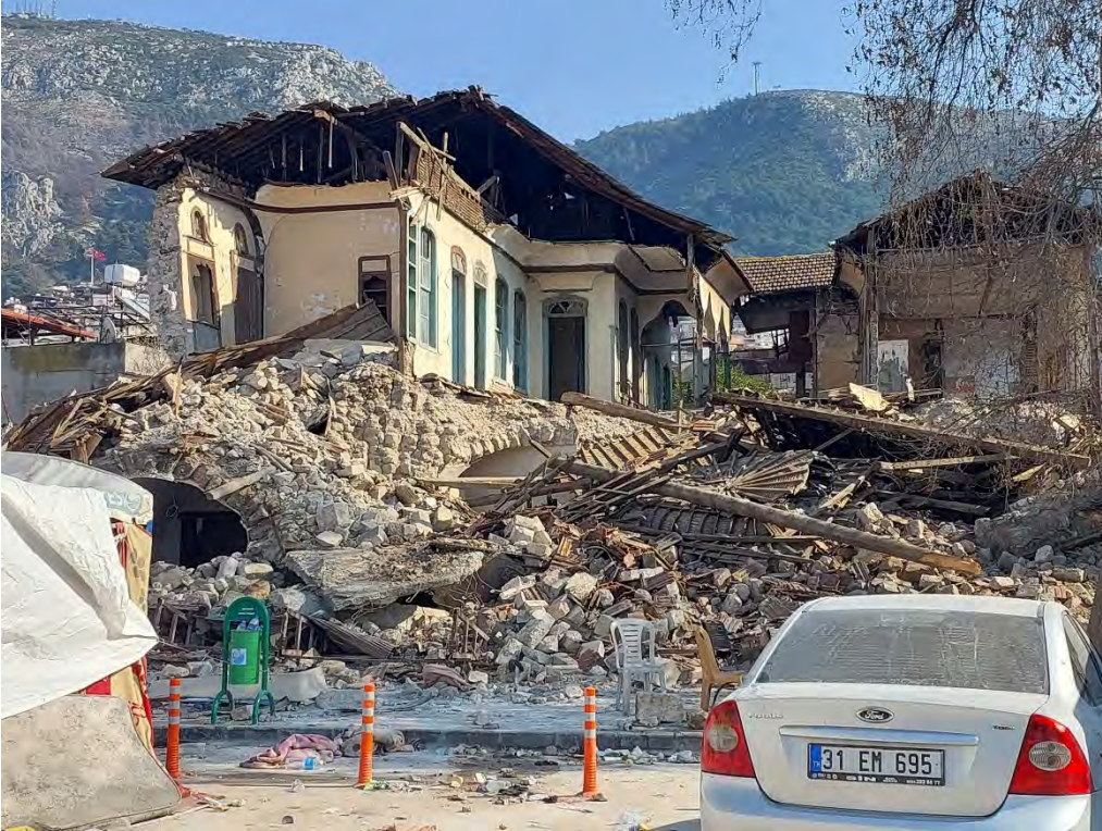
Antakya tarihî kent merkezinde yer alan sivil mimarlık eserlerinin 6 Şubat 2023 depremlerinden aldığı hasarlardan örnekler
