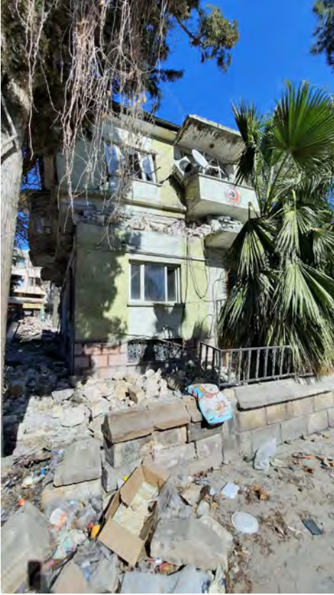
Adıyaman Orman Genel Müdürlüğü Lojman Binası
