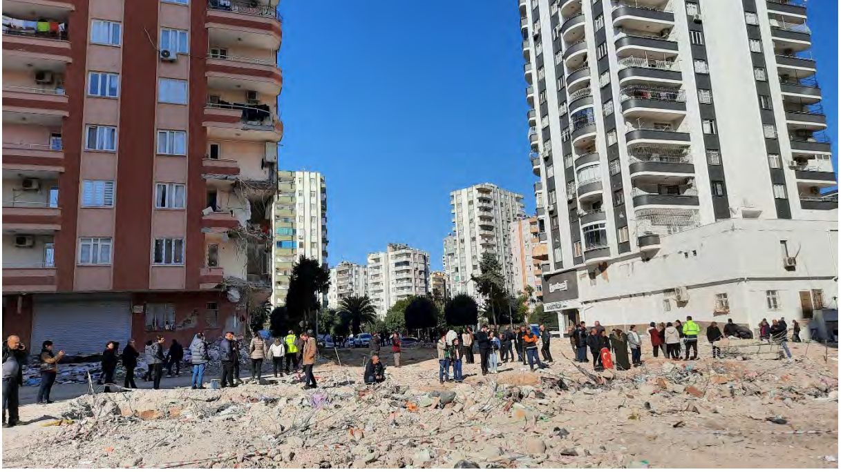
Adana – Kent merkezi yıkılan yapılar
