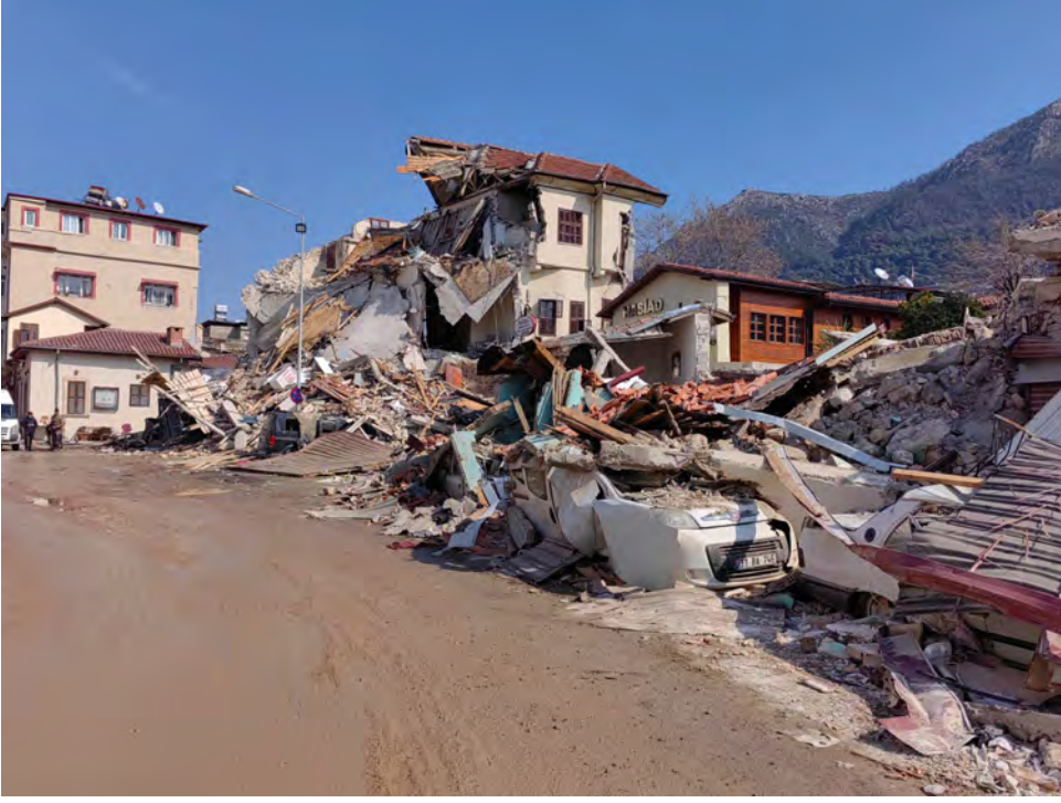
Antakya tarihî kent merkezinde yer alan sivil mimarlık eserlerinin 20 Şubat 2023 depreminden aldığı hasarlardan örnekler (Fotoğraf: Doç. Dr. Koray Güler)
