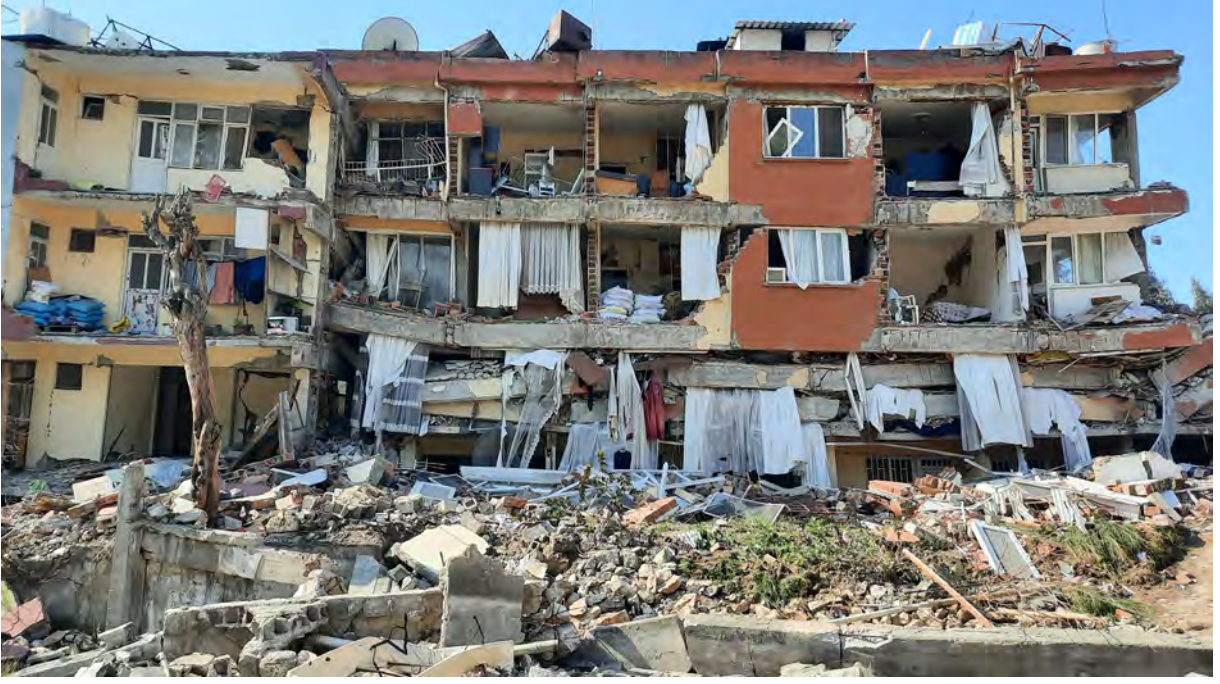
Hatay – kent merkezi ağır hasar gören ve yıkılan yapılar
