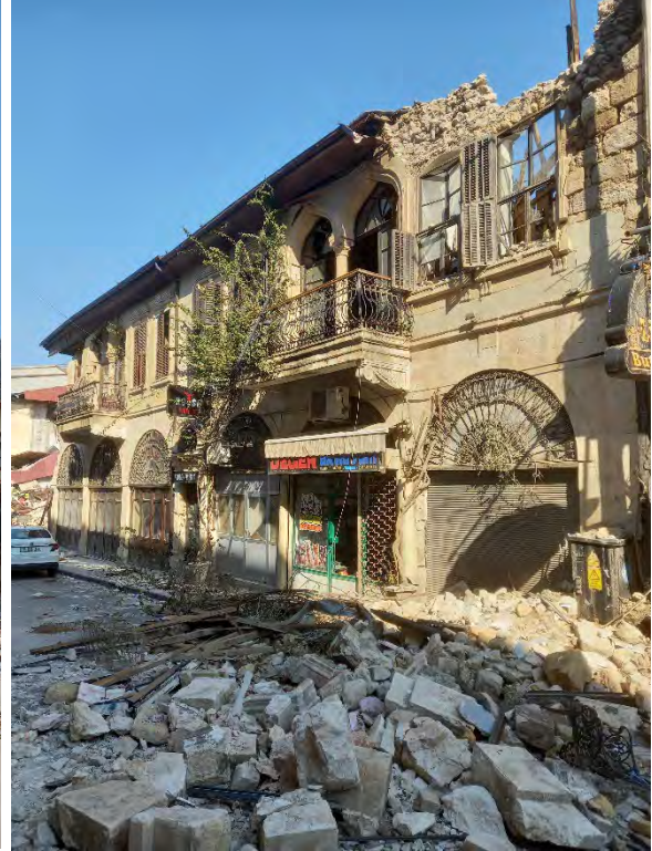
Antakya tarihî kent merkezinde yer alan sivil mimarlık eserlerinin 6 Şubat 2023 depremlerinden aldığı hasarlardan örnekler (Fotoğraf: Doç. Dr. Koray Güler)
