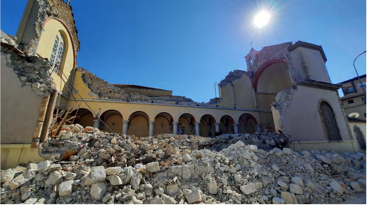
İskenderun Latin Katolik Kilisesi deprem sonrası hasar durumu
