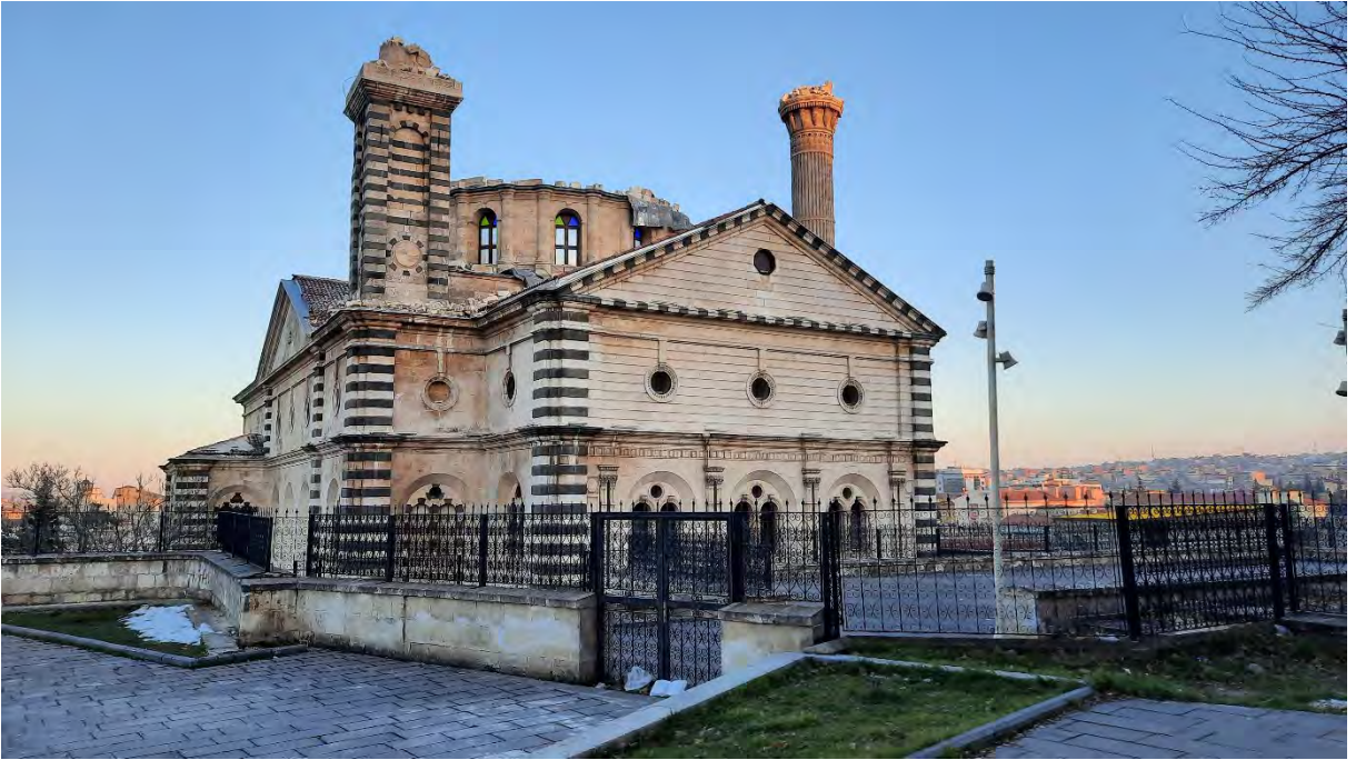
Kurtuluş Camisi'nde deprem sonrası gözlenen hasarlar
