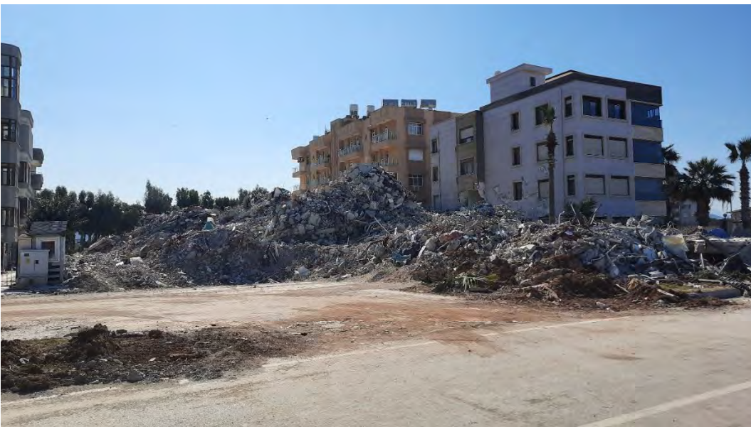
İskenderun – Sahil bandında yıkılan çok katlı yapılar
