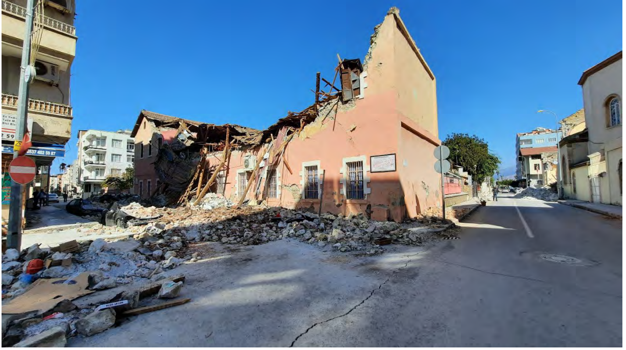
İskenderun Mithatpaşa Ortaokulu olarak kullanılmakta olan eski Fransız Elçiliği deprem sonrası hasar durumu
