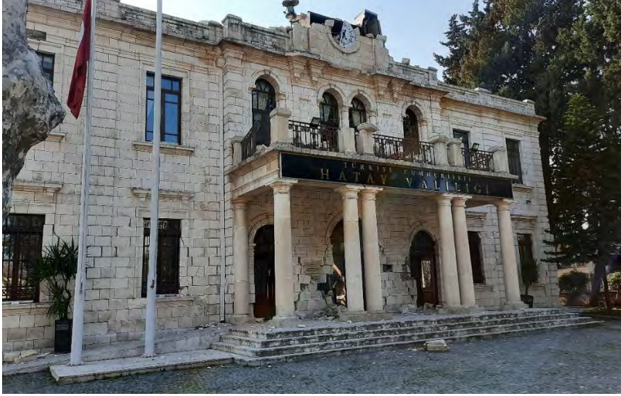
Hatay Hükümet Konağı (Valilik) 6 Şubat 2023 depremleri sonrası hasar
