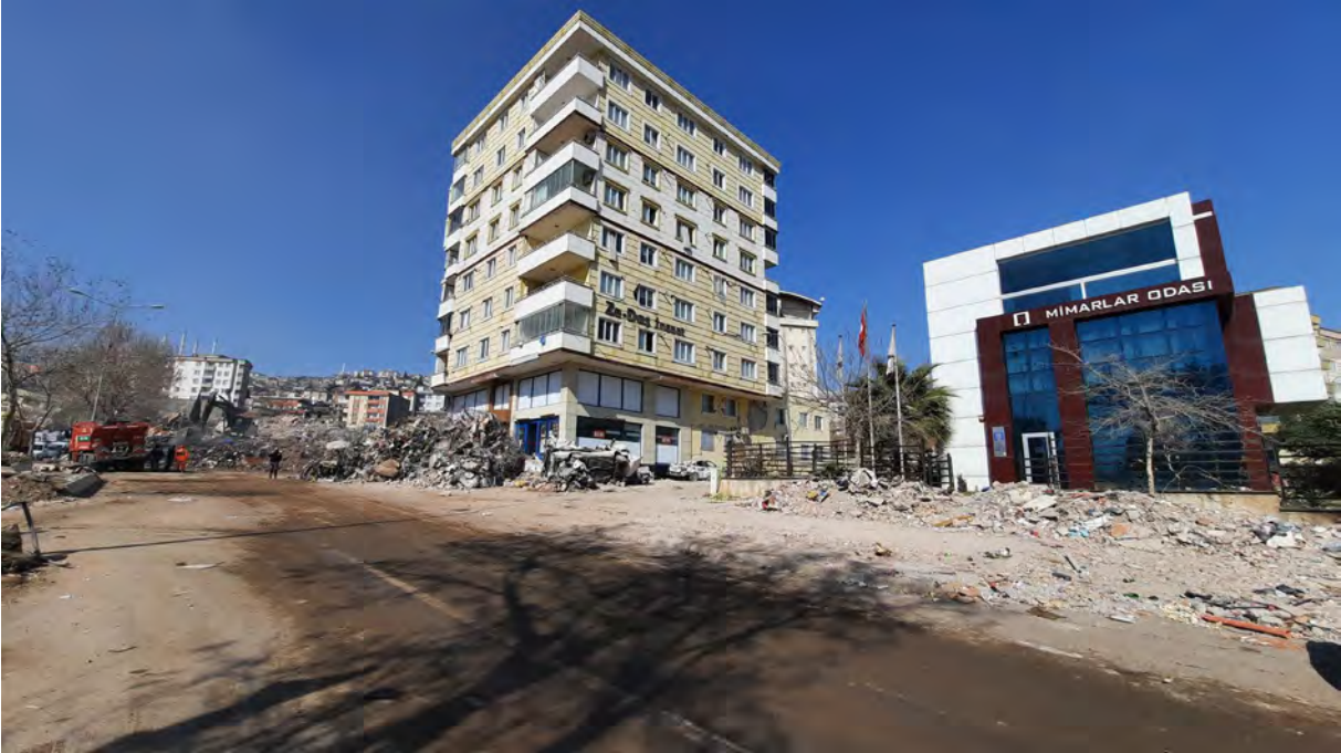
Mimarlar Odası Kahramanmaraş Şubesi Binası
