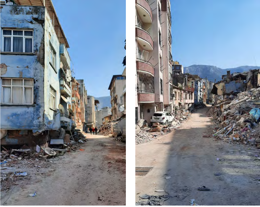
Hatay kent merkezi 6 Şubat 2023 depremleri sonrası hasar
