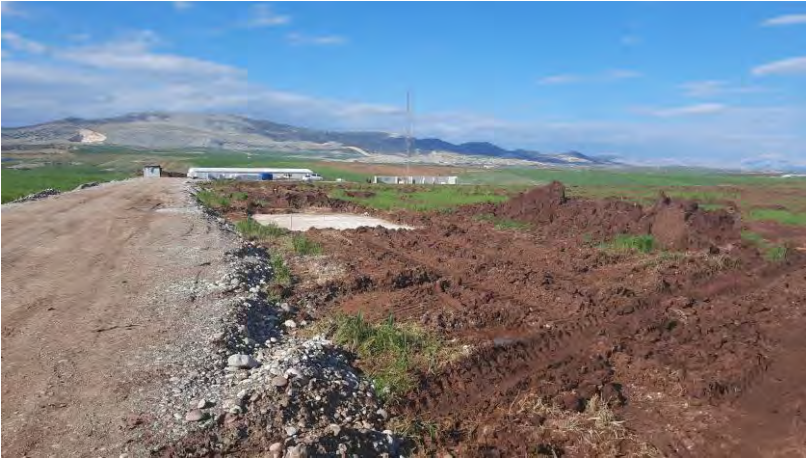
Örenli Kalıcı Konut İnşaat Alanı
