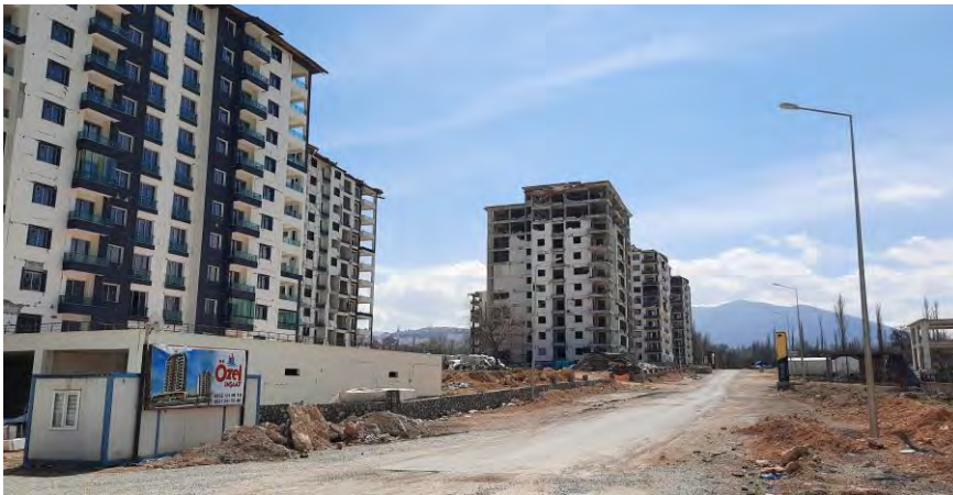
Malatya-Bostanbaşı’nda Yeni Ancak Ağır Hasarlı Durumdaki Yapılar
