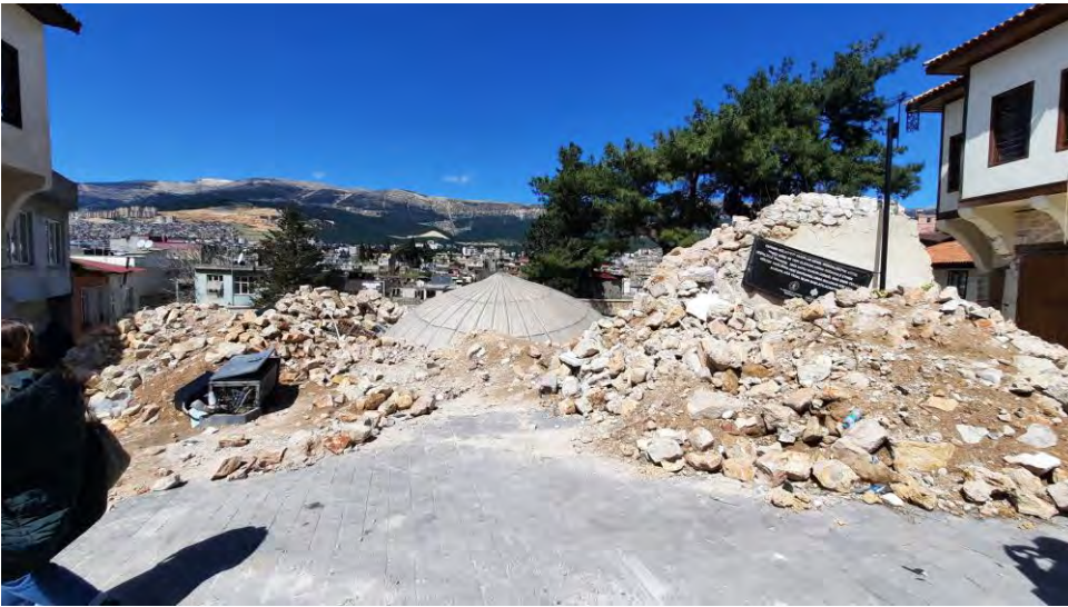
Restore Edilmiş Ancak Yıkık / Ağır Hasarlı Durumdaki Yapılar, Kahramanmaraş
