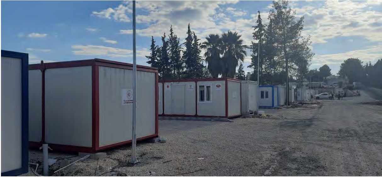
Altınşehir SANKO konteynerkent yerleşim alanı ve birimler - 2100 konteyner kurulumu
