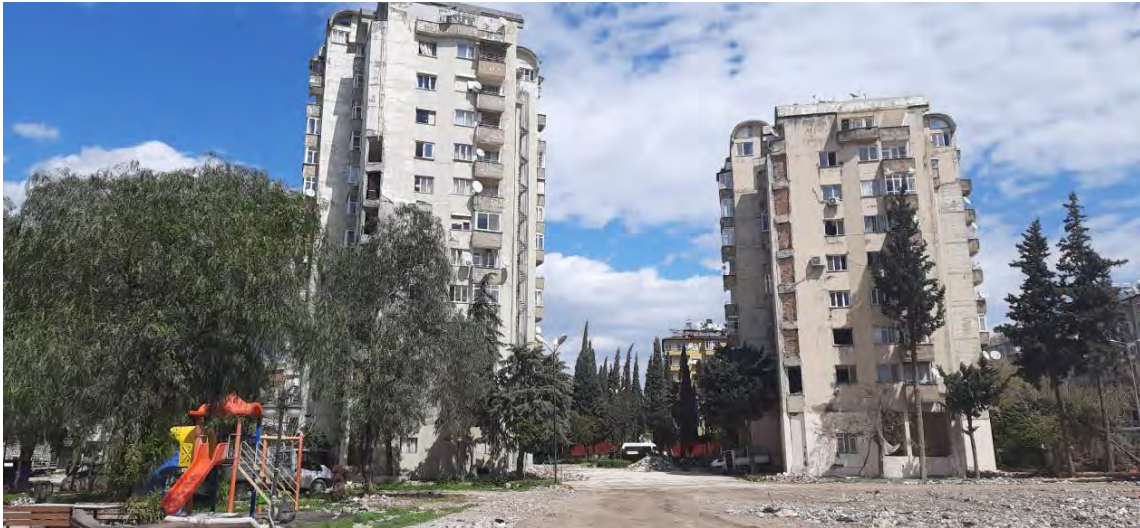
Hatay'da Güçlendirme Yapılan Belediye Blokları
