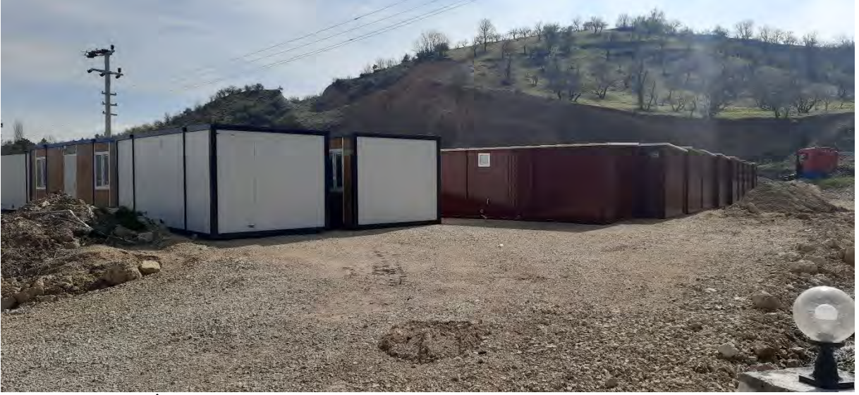
Malatya Battalgazi İlçesi Kanalboyu Caddesinde işyerleri ve esnaf için prefabrik yapılar kurulmaktadır.
