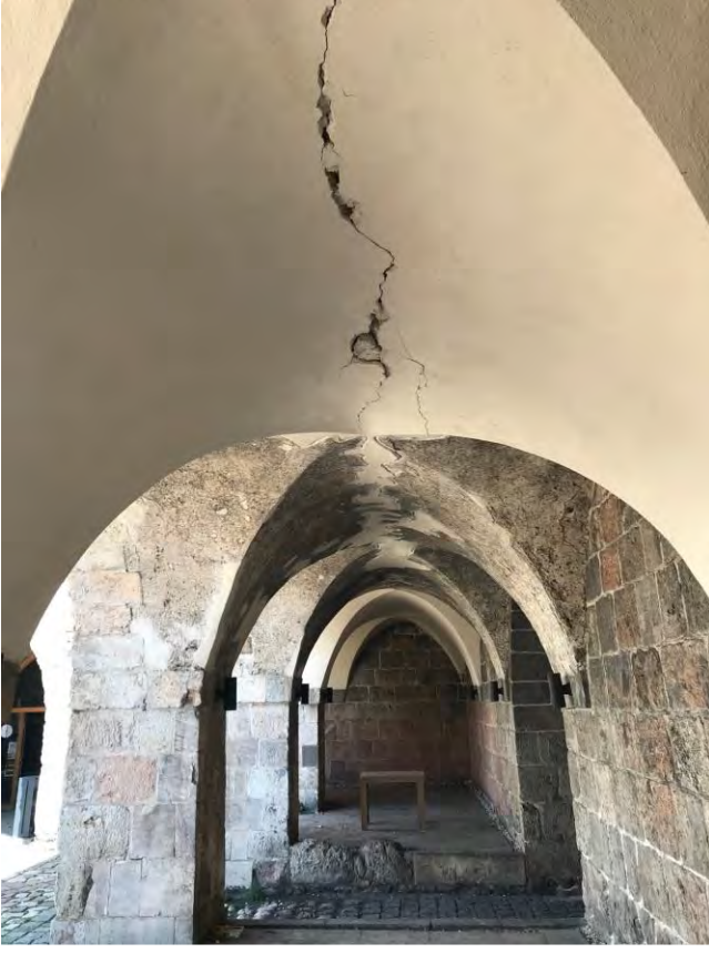
Payas, Sokullu Mehmet Paşa Kervansarayı kuzey revağı
