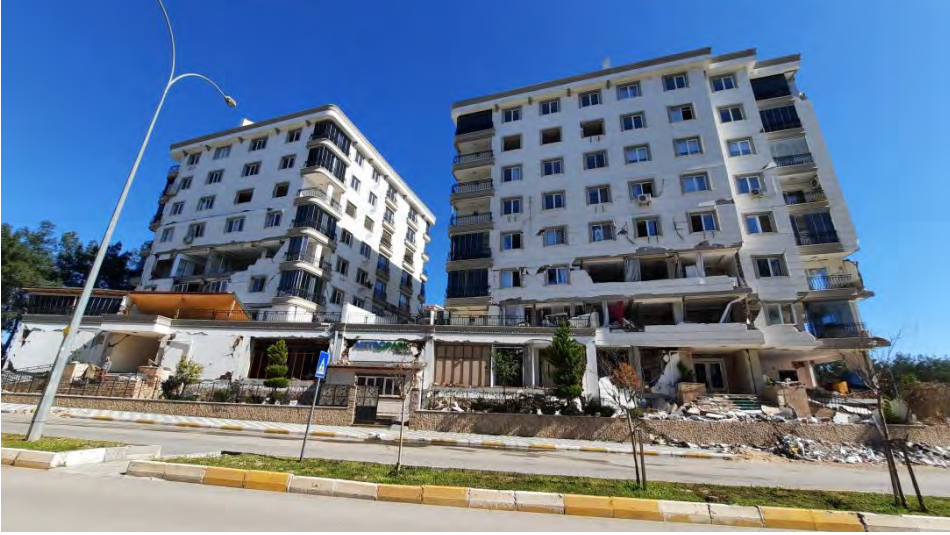
Adıyaman-Altınşehir Yeni Ağır Hasarlı Yapılar
