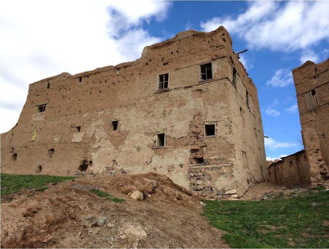
Balaban 2016; Depremden 7 yıl öncesinde aynı evin görünümü (Balaban'ın en eski en görkemli yapılarından biri depremde en az hasarı alan yapı)
