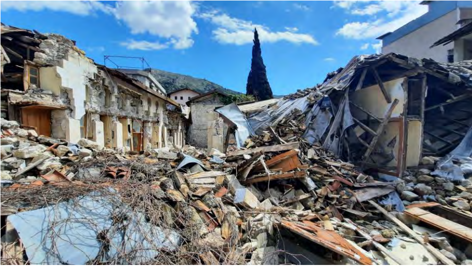
Restore Edilmiş Ancak Yıkık / Ağır Hasarlı Durumdaki Yapılar, Hatay
