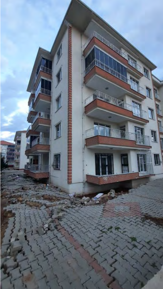
Gölbaşı'nda zemin sıvılaşması hasar örnekleri
