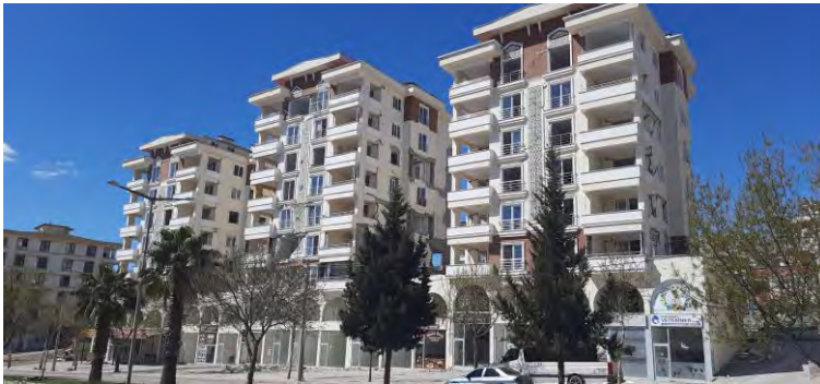
Kahramanmaraş Doğukent Yeni Ağır Hasarlı Yapılar
