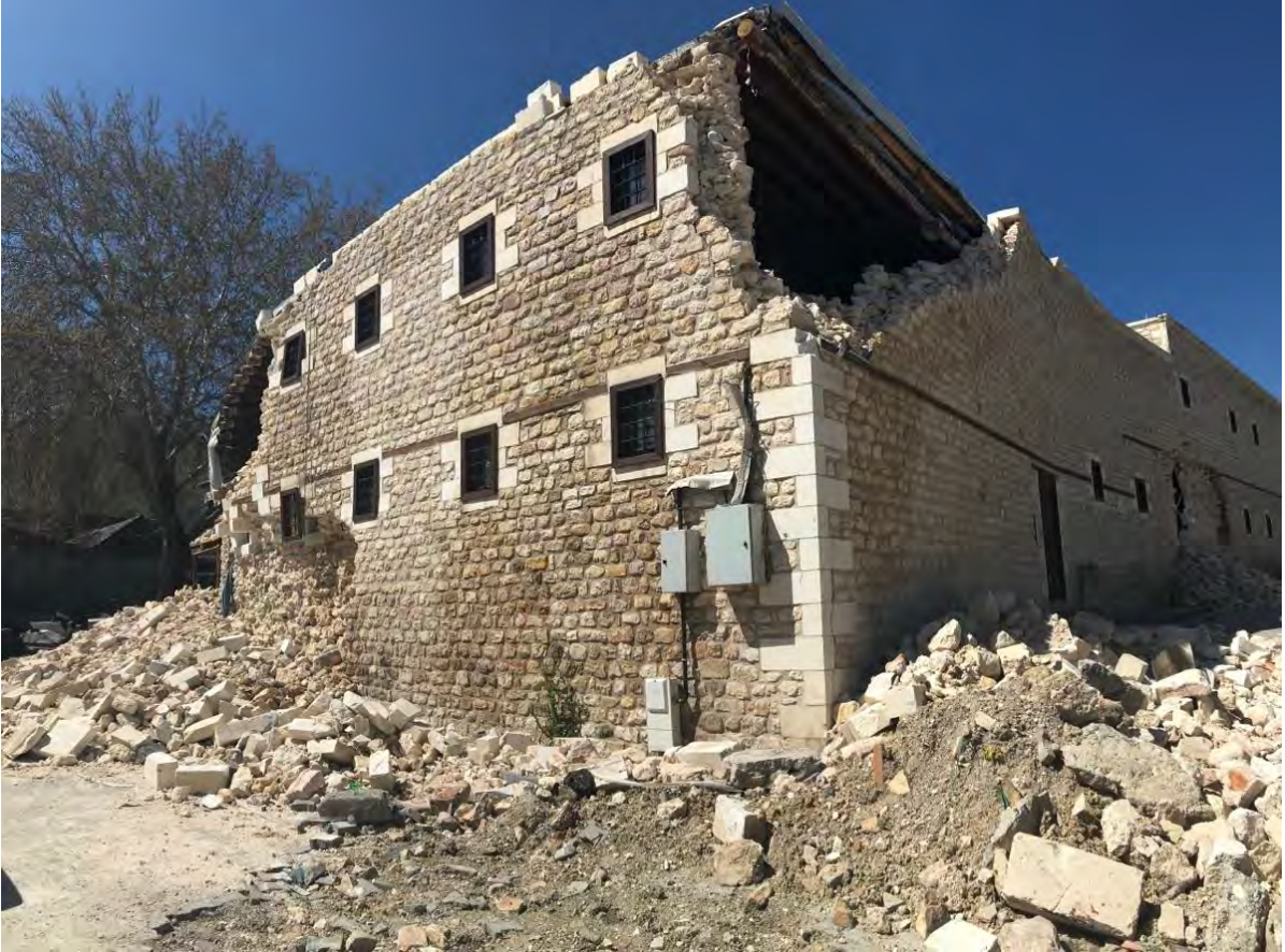
Adıyaman, yakın dönemde restorasyon uygulamaları geçiren Tuz Hanı'nda hasarlar
