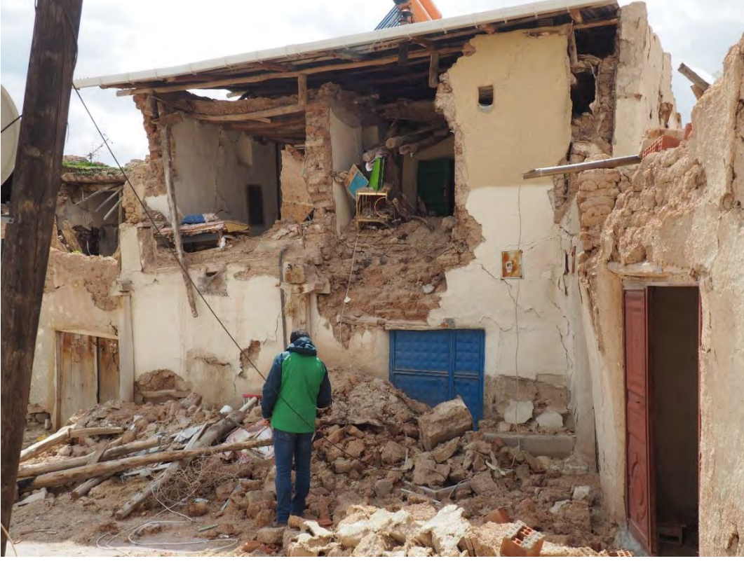
Balaban, üst kat duvarları yıkılmış yapı
